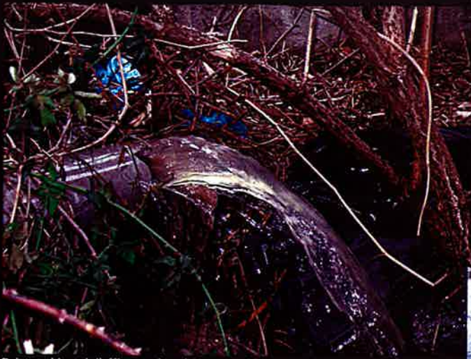
Rejet accidentel d'effluents dans la Reppe - 2005
